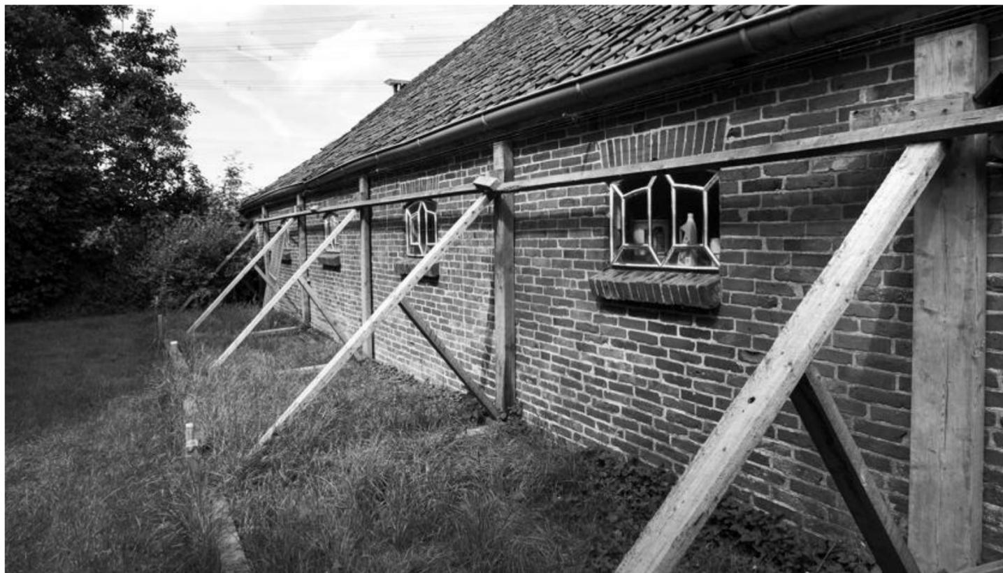
▲ Viele der alten Bauernhöfe in Groningen sind durch das Erdbeben schwer beschädigt, dass sie abgestützt werden müssen
